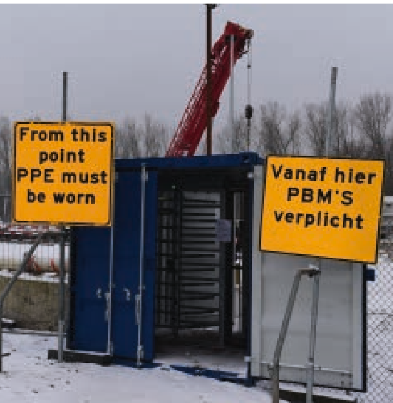
Streng toegangsbeleid op de bouwplaats.
